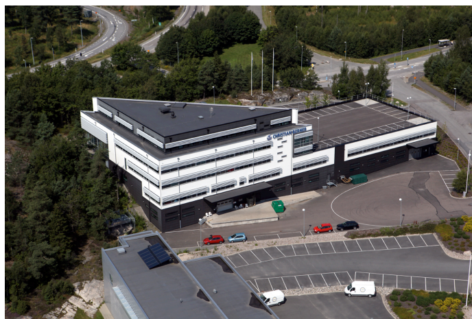
Fastigheten Härryda Solsten 1:118 har en uthyrningsbar yta på cirka 5 000 kvadratmeter. Christian Berner Tech Trade AB har sitt huvudkontor här sedan fastigheten byggdes 2006.
